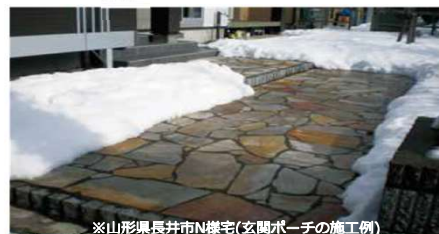
※山形県長井市N様宅(玄関ポーチの施工例)
